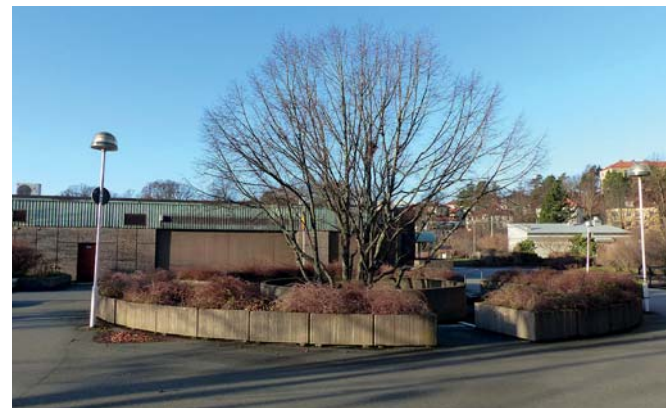
11. Nedan: Rund genomföring till garaget. Entrén till mataffären var tidigare i den igensatta delen av byggnaden bakom.
