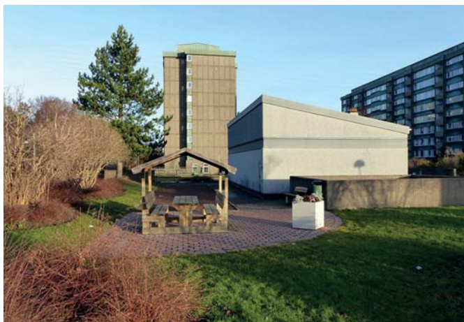
8. Ovan: Gårdens södra del med sopsugsanläggningen.
