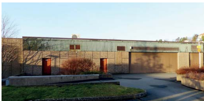
Ovan: Byggnadens strama fasader med neddragen takkant i koppar. Den igensatta butiksentrén till höger i bild.
